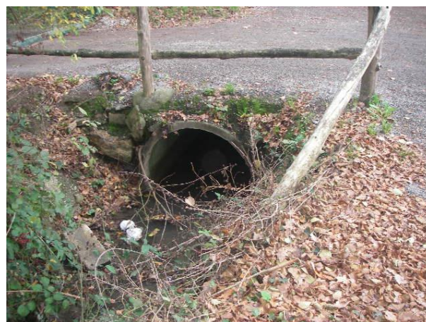
Passage busée sur le ruisseau des Bozées
