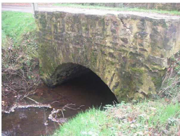
Pont sur le Fresne
