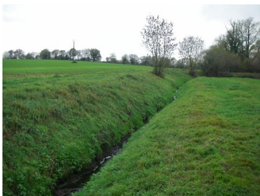
Plusieurs travaux d'hydrauliques ont été effectués sur le ruisseau de la Fromagerie
