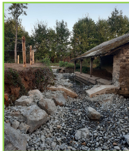
Aménagement continuité sur le lavoir communal à ST GERMAIN LE FOUILLOUX
