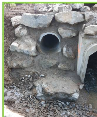
Buse sèche pour passage faune
