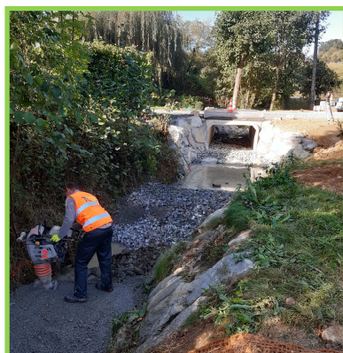
Pont cadre et mise en charge en aval par seuils successifs
