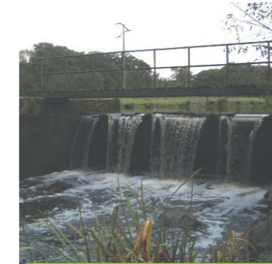
La valette St Cénére : avant travaux
