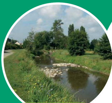
Bourg de Neau - 4 ans après travaux, les berges sont toujours en place
