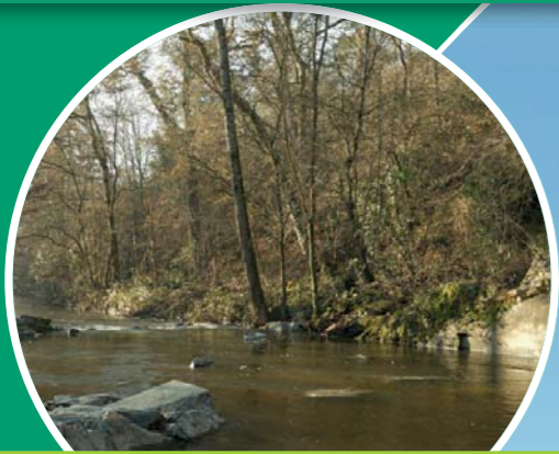
Site du Béliér à Entrammes : Renaturation suite au démantèlement d'un barrage – resserrement du lit par mise en place d'un épis en enrochement, recharge de radier et pose de blocs pour diversifier les écoulements.
