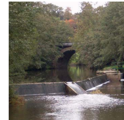
Le pont St Cénére avant travaux
