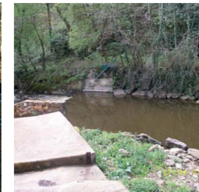
Seuil du Béliér : avant travaux
