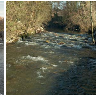
Après démantèlement du seuil de la Molaiserie à Entrammes (remplacement par une rampe en enrochement)
