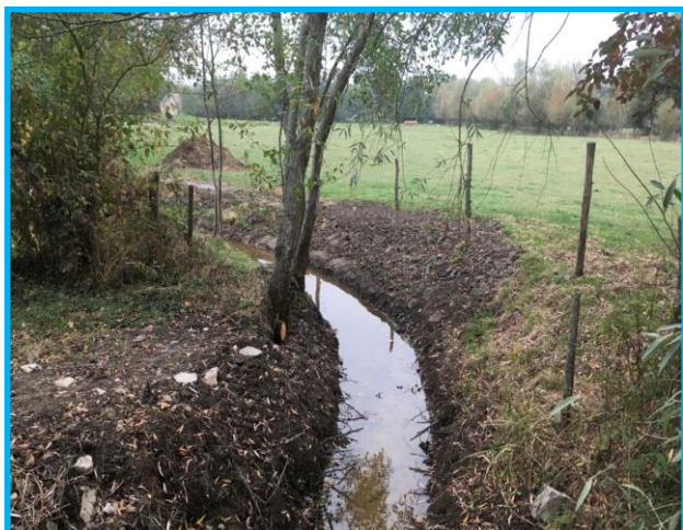
Curage du bief
